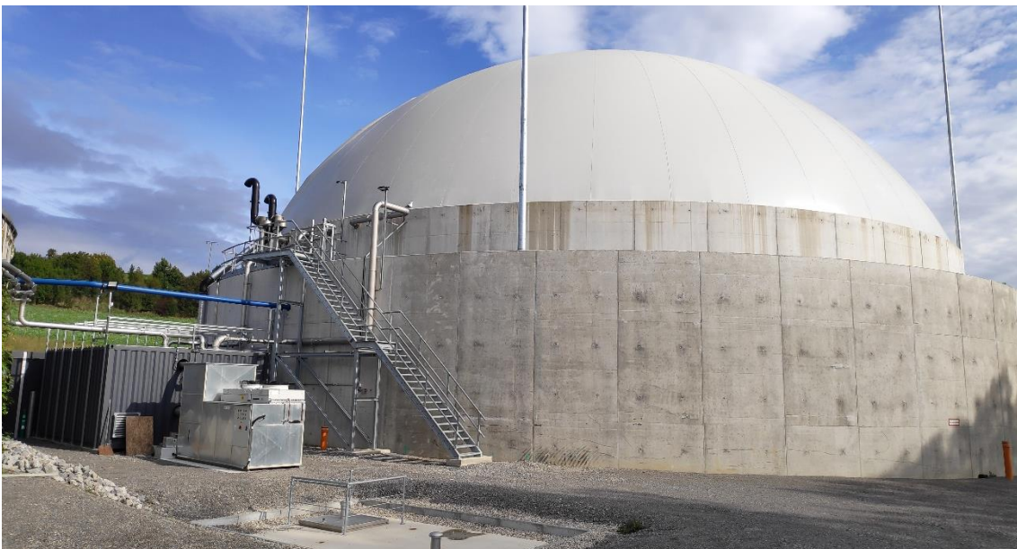
Abb. 2: Foto des FD-Speichers 3 mit umgebendem Havariebecken
