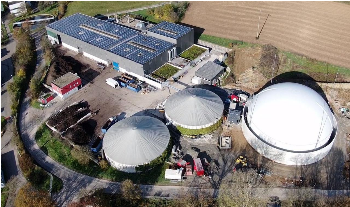
Abb. 1: Luftbild aus der Bauphase der Anlagenerweiterung
